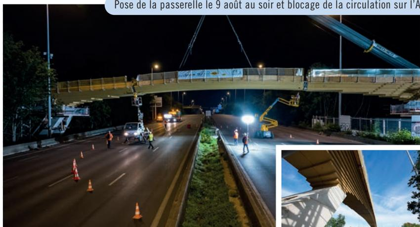
Pose de la passerelle le 9 août au soir et blocage de la circulation sur l'A1.
