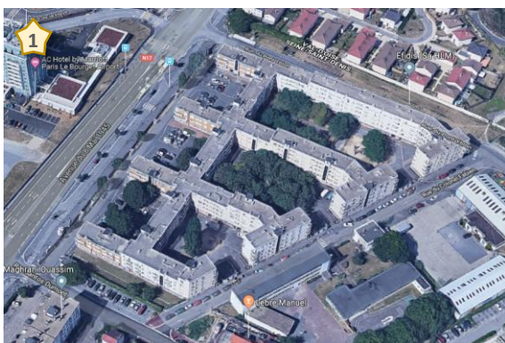
Cité du Pont Yblon des années 1920-1930, DUGNY
