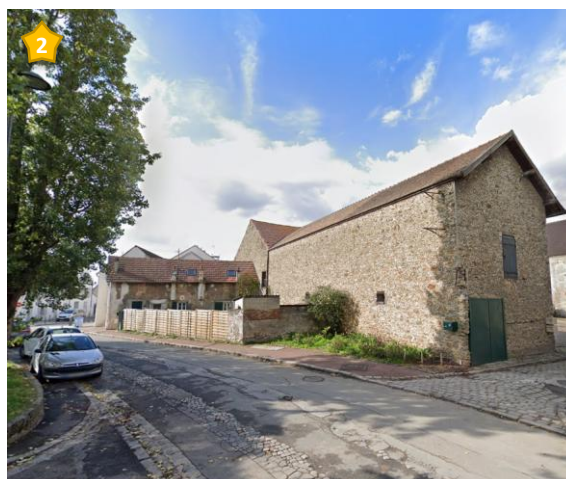
Corps de ferme, TREMBLAY-EN-FRANCE
