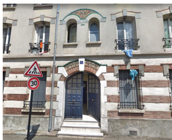
Immeuble, LE BOURGET
