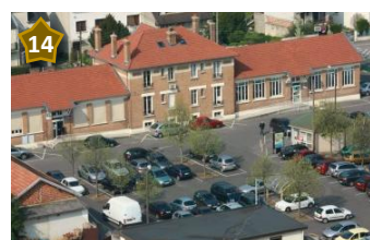
Centre administratif, VILLEPINTE
