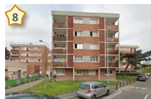
Résidence Balagny, AULNAY-SOUS-BOIS
