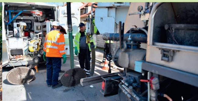
Ouvrage de la noue du parc Montceaux à Sevran et inspection du réseau sur le territoire.
