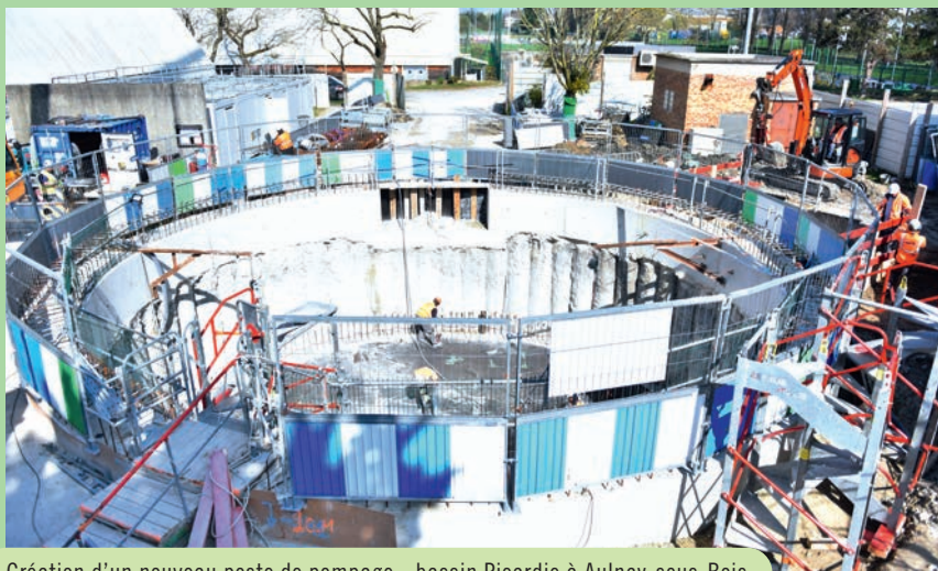
Création d'un nouveau poste de pompage - bassin Picardie à Aulnay-sous-Bois.
