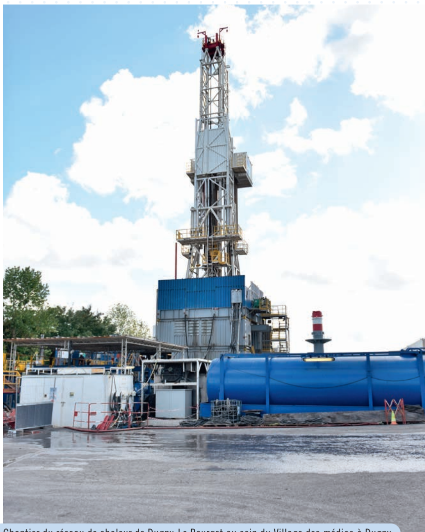
Chantier du réseau de chaleur de Dugny-Le Bourget au sein du Village des médias à Dugny.
