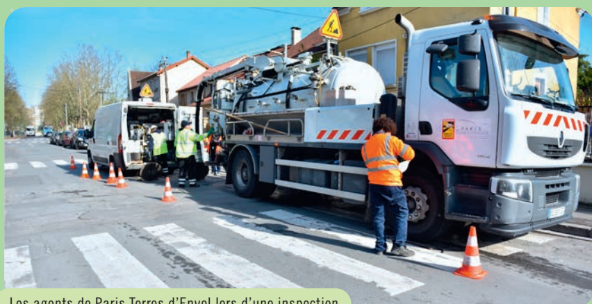
Les agents de Paris Terres d'Envol lors d'une inspection.
