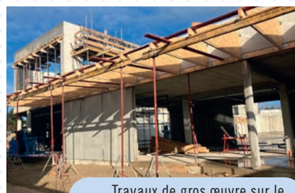
Travaux de gros œuvre sur le chantier du gymnase de Dugny.
