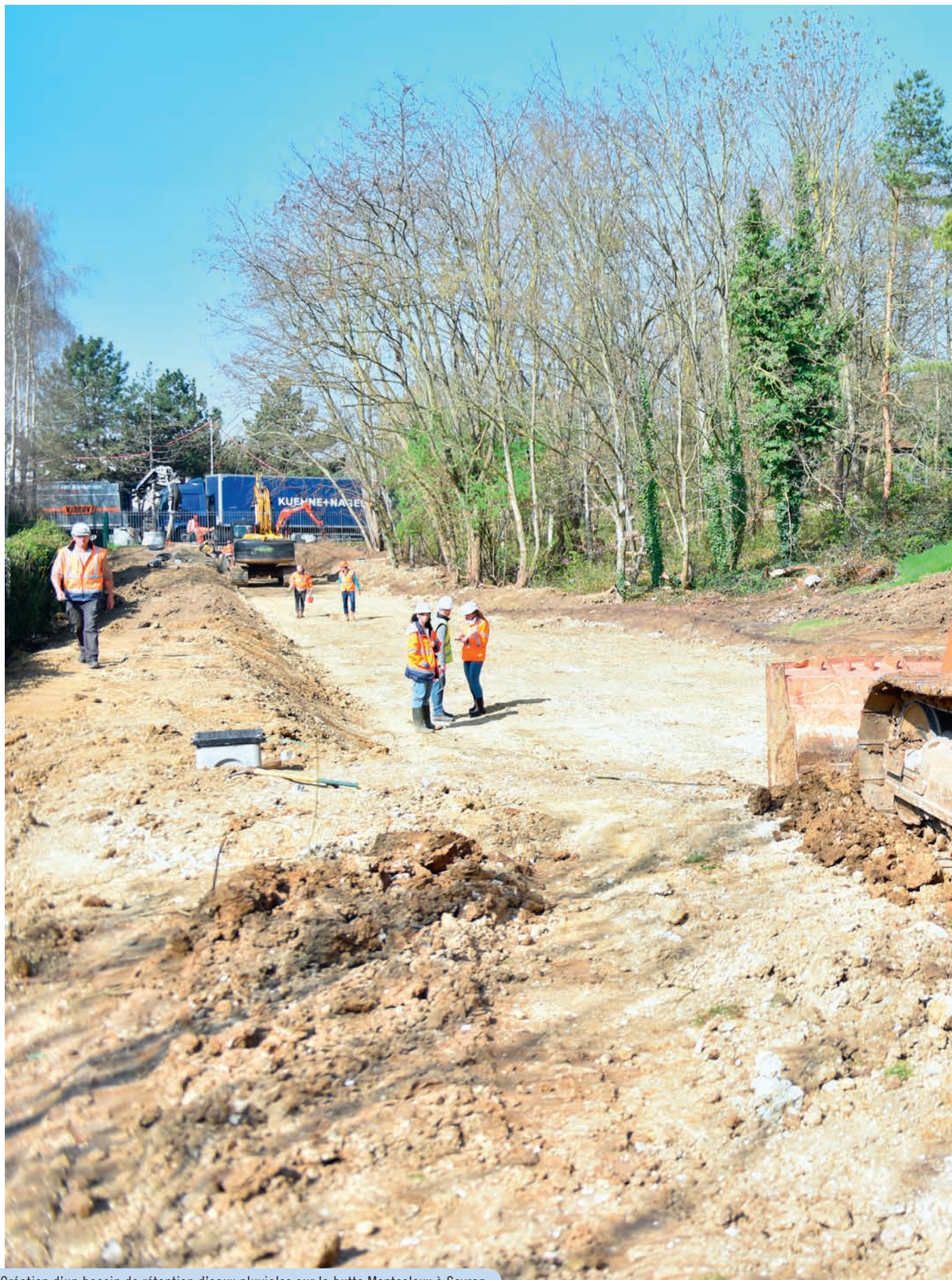
Création d'un bassin de rétention d'eaux pluviales sur la butte Montceaux à Sevran.
