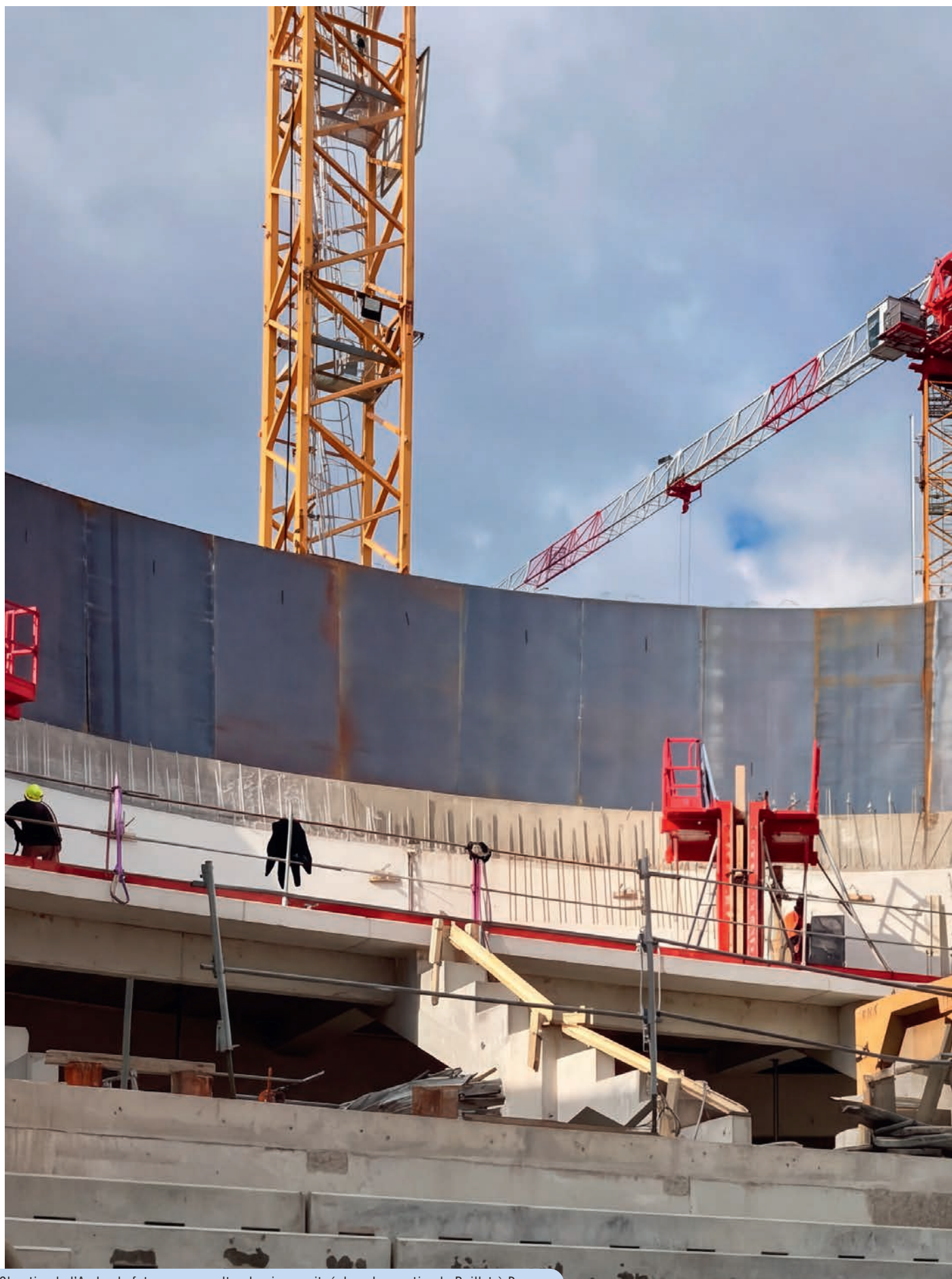
Chantier de l'Arche, le futur espace culturel qui sera situé dans le quartier du Baillet à Drancy.
