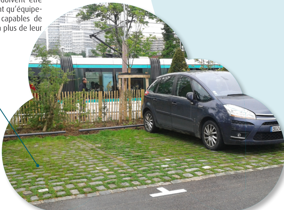
Parking infiltrant évitant l'imperméabilisation, Fresnes (DRIEE)
