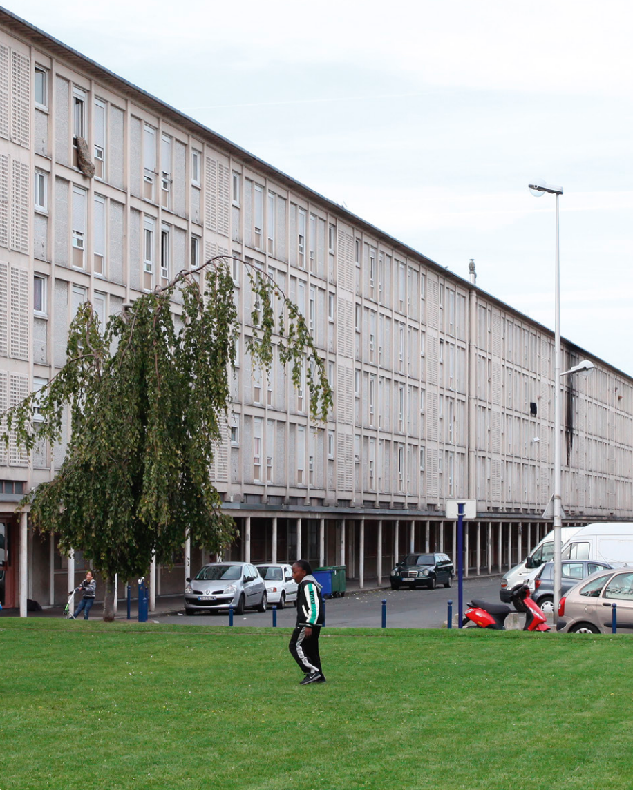
Quartier d'habitat collectif à Drancy.
